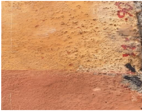
Photo 8 : La couleur de la surface devenue foncée après passage à la flamme
