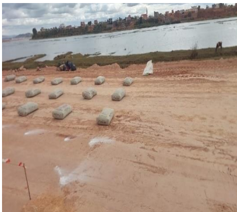
Photo 3: Dépôt des sacs de ciment
