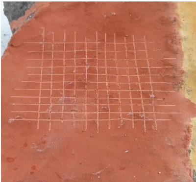
Photo 4 : Test de quadrillage et d'adhérence sur le béton
