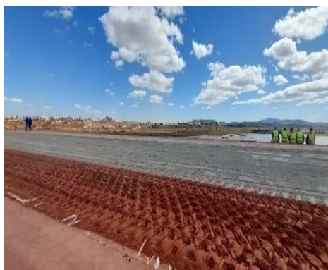
Photo 4: Epannage ciment sur sol
