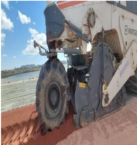
Photo 5: Mise en œuvre du sol ciment
